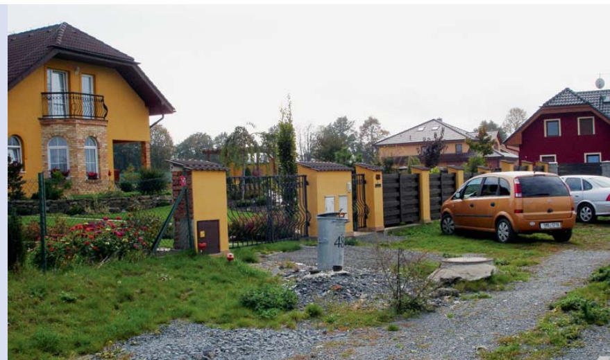
V některých nových čtvrtích domy již dávno stojí, potřebné komunikace však ještě nebyly dokončeny. Výsledkem jsou prашné cesty s vystupujícími hydranty a kanály. Foto: J. Novák (nahore), J. Temelová (dole).
